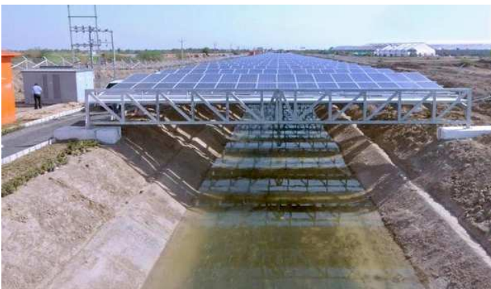
รูปที่ 2 การติดตั้งแผงโซลาร์เซลล์เหนือคลองนารมาดา ในรัฐกุจราตของประเทศอินเดีย
