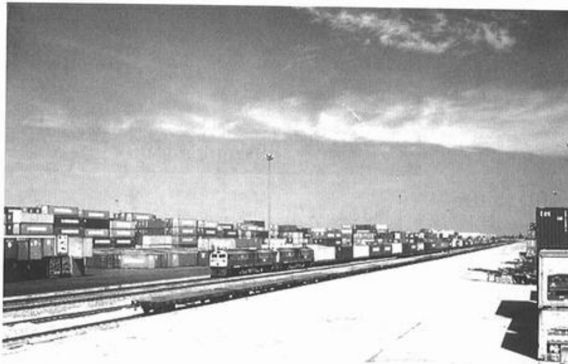
โครงการก่อสร้างสถานี ICD แห่งที่ ๒
