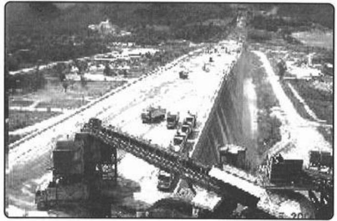
งานก่อสร้างระบบส่งน้ำและระบบระบายน้ำ
